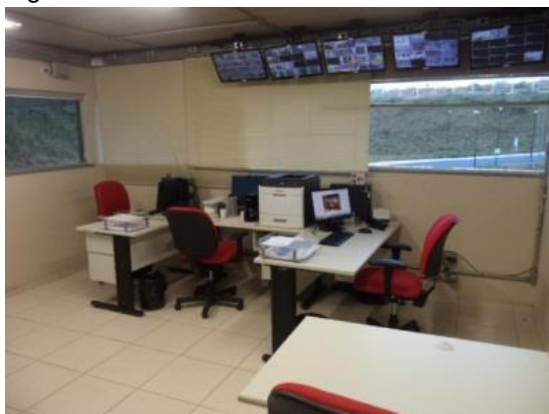
Figura 7: Sala de monitoramento
